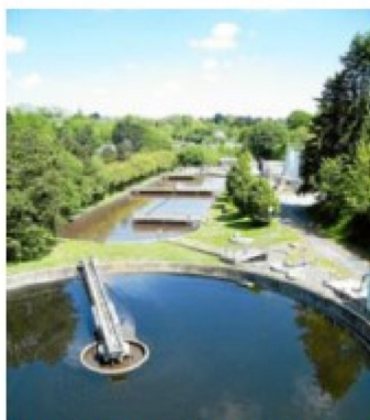
La nouvelle station d'épuration sera construite à deux pas de l'actuelle, route de Loguivy. Photo LTC
