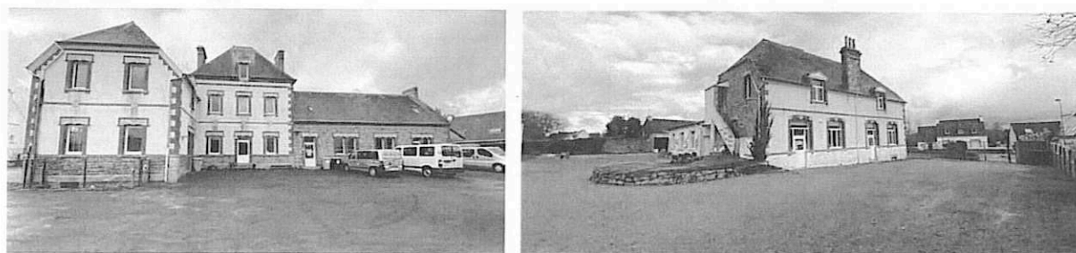
Vue des façades est et sud des bâtiments
