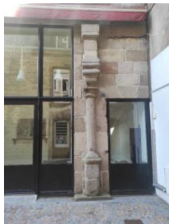
3 Colonne en pierre 11 rue Dugesclin
