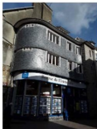
Immeuble - Le Flanhec, rue Dugescrin © Région Bretagne
