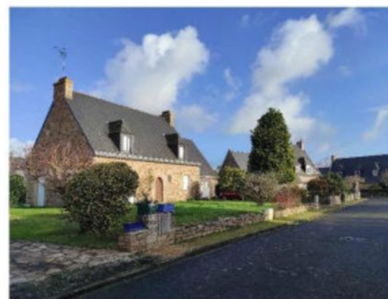
Lotissement de Brélévenez © BE-AUA
