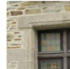
Encadrement des baies en pierre de taille et vitraux
