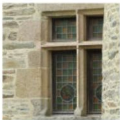
Fenêtre à meneaux
