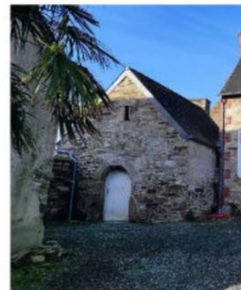
Rue du Hingar ©BE-AUA
