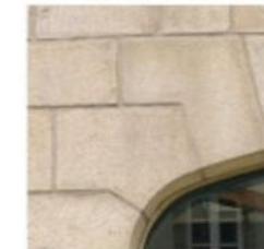
Mur en pierre de taille au rez-de-chaussée
