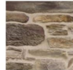
Mur en moellon
