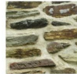
Mur en moellon
