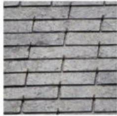
Couverture en ardoise
