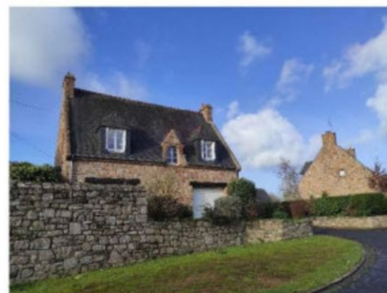
Lotissement de Brélévenez © BE-AUA
