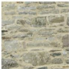
Mur en moellon
