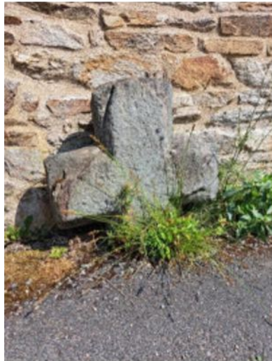
12 Croix au sol Rue de Pors an Prat
