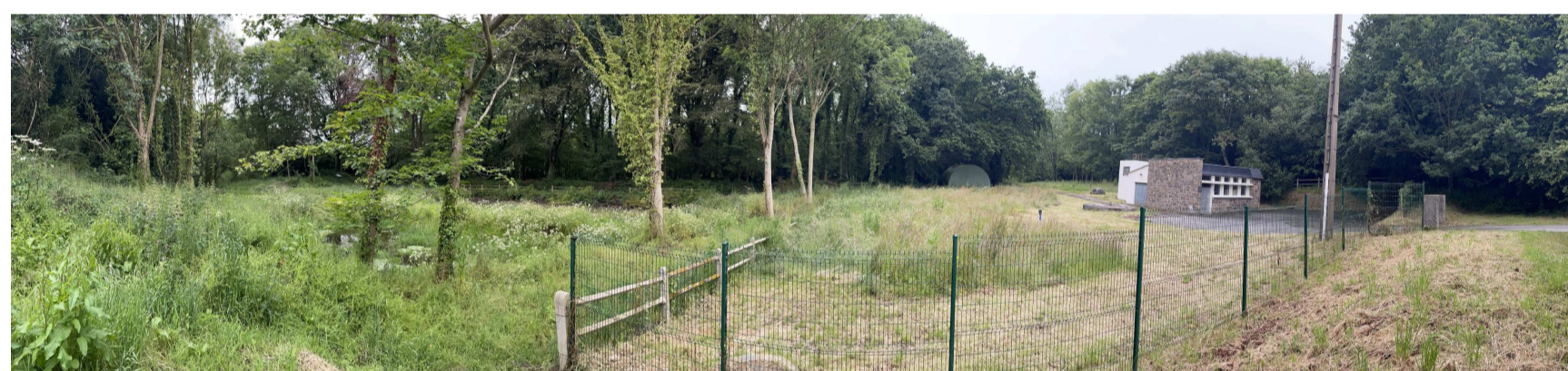
Vue de l'usine d'eau potable de l'Hôpital
