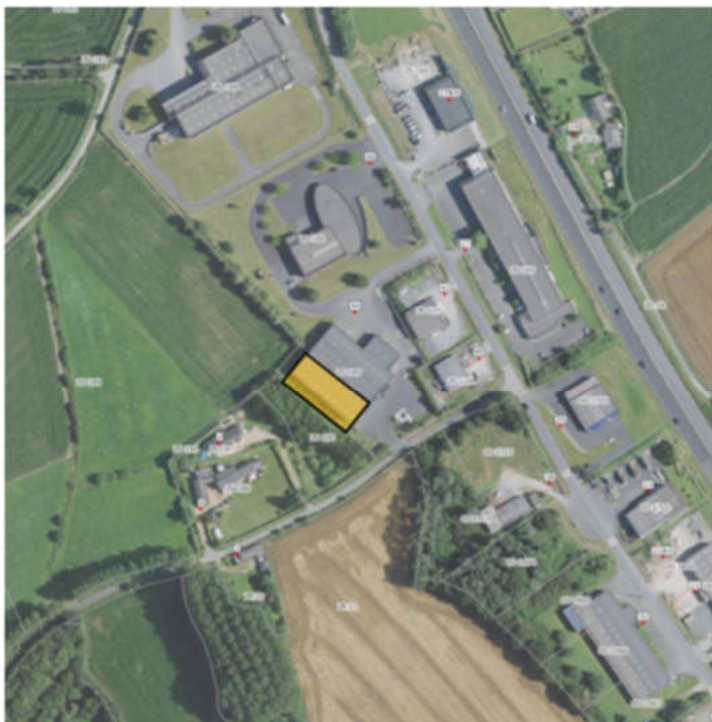
La parcelle cadastrée ZS n°185 a été densifiée en 2018 par la société UCN Meca qui a créé une extension à son bâtiment existant
