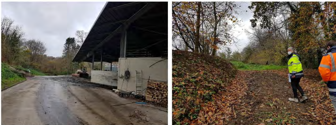
La jonction vers la parcelle en contrehaut de la station d'épuration existante.
