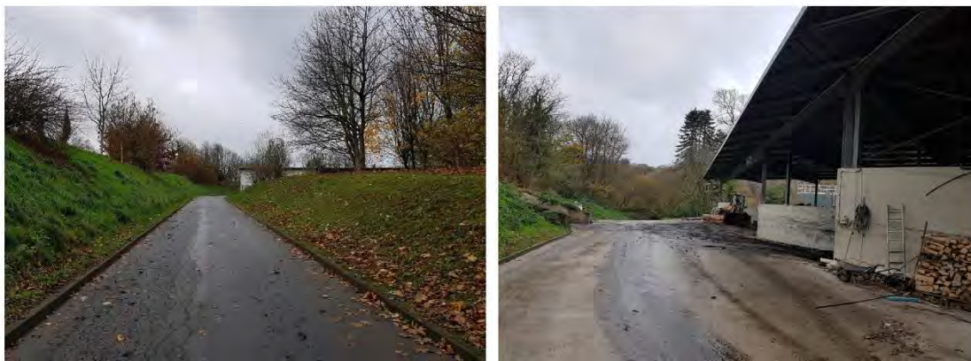
La voirie vers la partie haute du site qui est destinée à être raccordée à l'extension. On notera que le talus n'est plus boisé.
