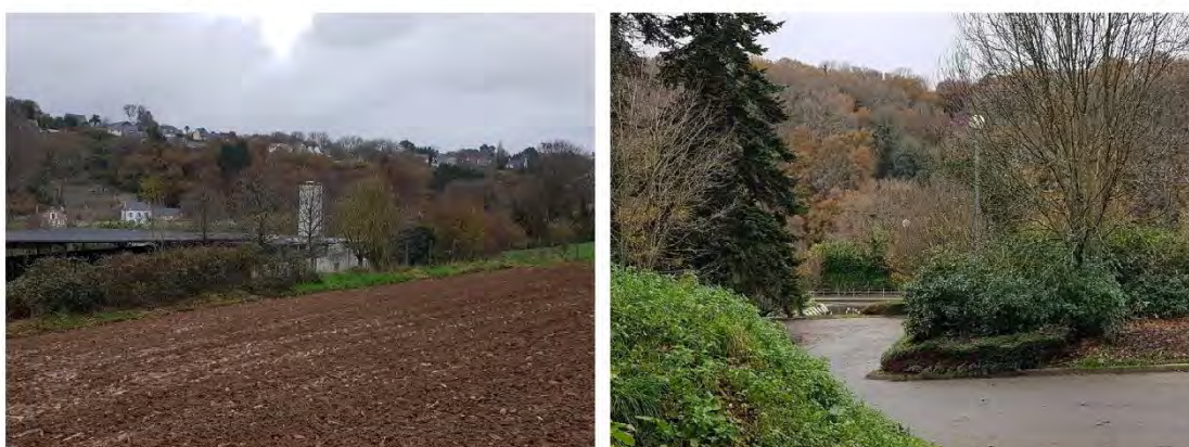
La vue depuis la parcelle agricole au-dessus de la station d'épuration existante et l'intérieur du site traité comme un parc horticole un peu incongru dans ce contexte forestier et plutôt naturel.
