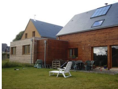
Ou par une dépendance (Langouët, architecte : Menguy)
