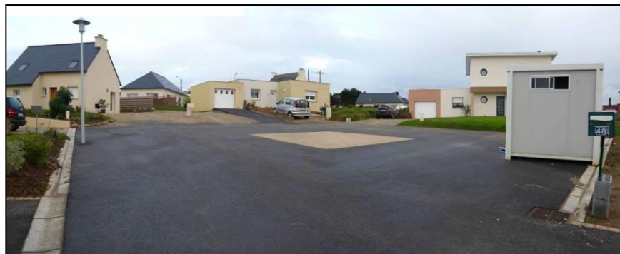
Les places démesurées au bout de voies en impasses
