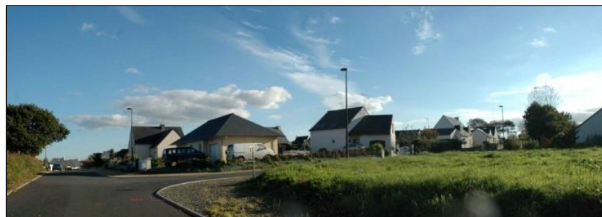
Logements semi-collectifs à Keruncun, en bande à Croas Lescop, individuels au Port et à Keruncun
