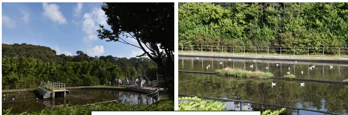
Clichés 13 et 14 : vues sur les bassins de traitement
