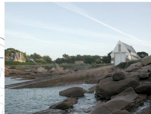
Abri du canot de sauvetage et sa cale – Ploumanac'h © CD22
