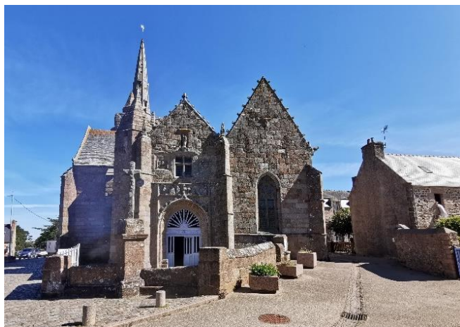
Figure 20 - Vue sur la chapelle depuis la place © BE-AUA
