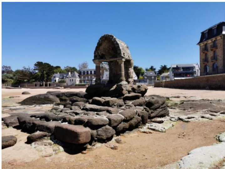
Figure 16 - Vue générale de l'oratoire © BE-AUA
