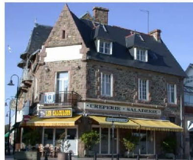
Maison avec commerce rue du Maréchal Leclerc – Balnéaire et littoral © CD22
