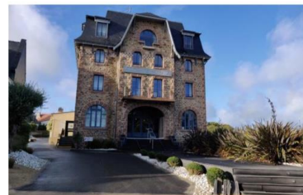
Parking de l'Hôtel Castel Beau Site © MM
