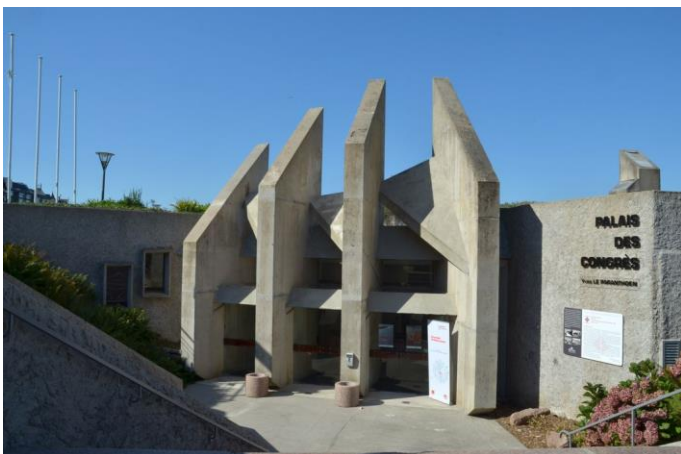
Figure 22 - Vue sur la façade principale © BE-AUA
