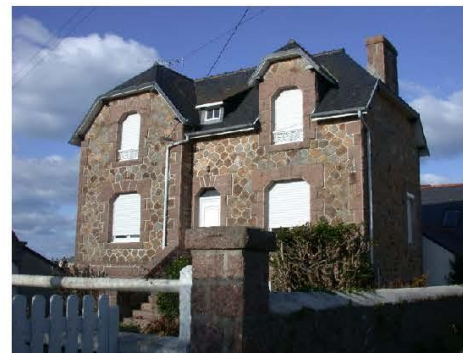
Maison rue du port – Ploumanac'h © CD22
