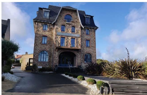
Castel Beau Site – Ploumanac'h © BE-AUA
